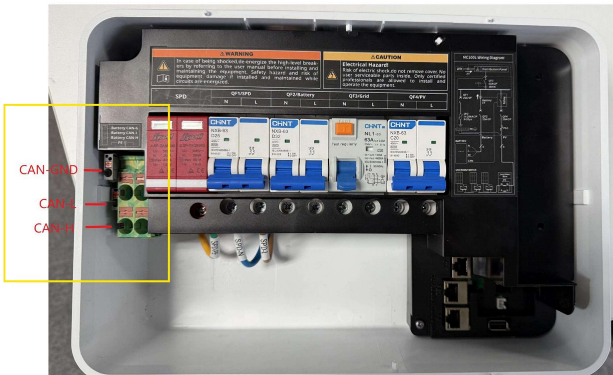
Imagen 12. En amarillo bornero de comunicación de MC100L
