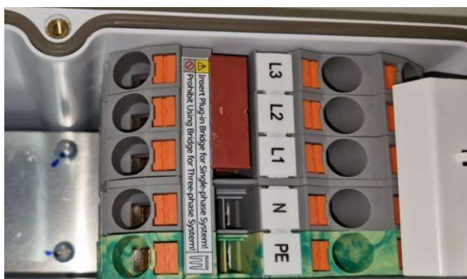
Imagen 7. Puente de Batería obligatorio conectar en escenario monofásico
