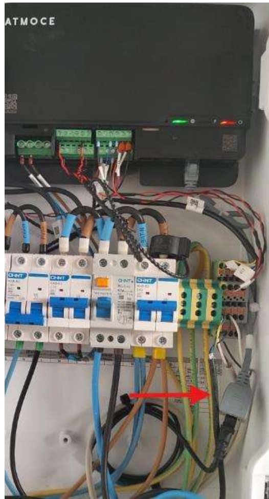
Imagen 15. Conector RJ45 hembra para conexión de toroidal de consumo
