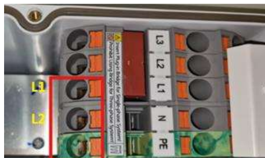
Imagen 7. Puente de Batería obligatorio conectar en escenario monofásico/Bifásico
